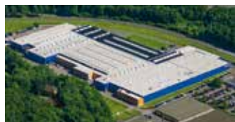
Hörmann KG Eckelhausen, Allemagne
